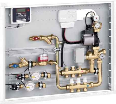
Particolare cassetta di stacco utenza alta/ bassa temperatura installata in FORESTERIA
